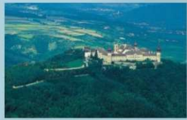
Die barocke Stiftsanlage wurde vom Architekten Johann Lucas von Hildebrandt erbaut, nachdem das alte Kloster durch einen Brand 1718 zerstört wurde.
